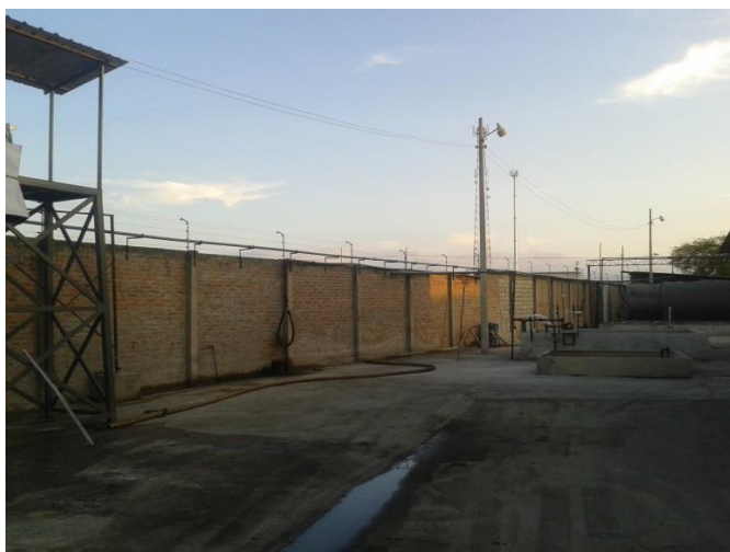
Ilustración 4 Sistema de tubería desde el Pozo de Acopio de Aguas Residuales hasta el tamiz rotativo Fuente: Autor
