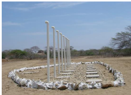
Imagen 11 esquema general del sistema séptico instalado
