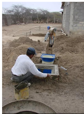
Imagen 3 colocacion de cajas de aceras a lo largo de la via de ingreso
