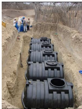
Imagen 5 instalación de serie de tanques, sitio de recolección de aguas residuales
