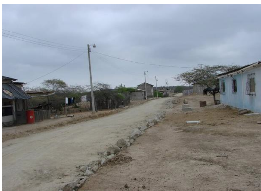
Imagen 4 colocacion de cajas de aceras a lo largo de la via de ingreso
