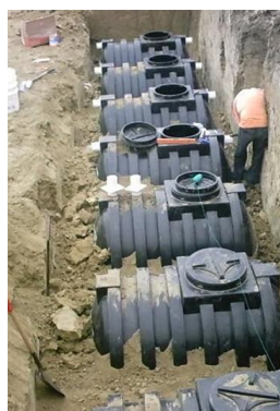
Imagen 5 instalación de serie de tanques, sitio de recolección de aguas residuales
