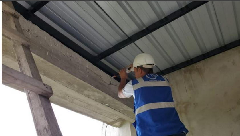
Figura 8. Esclerometría a vigas
