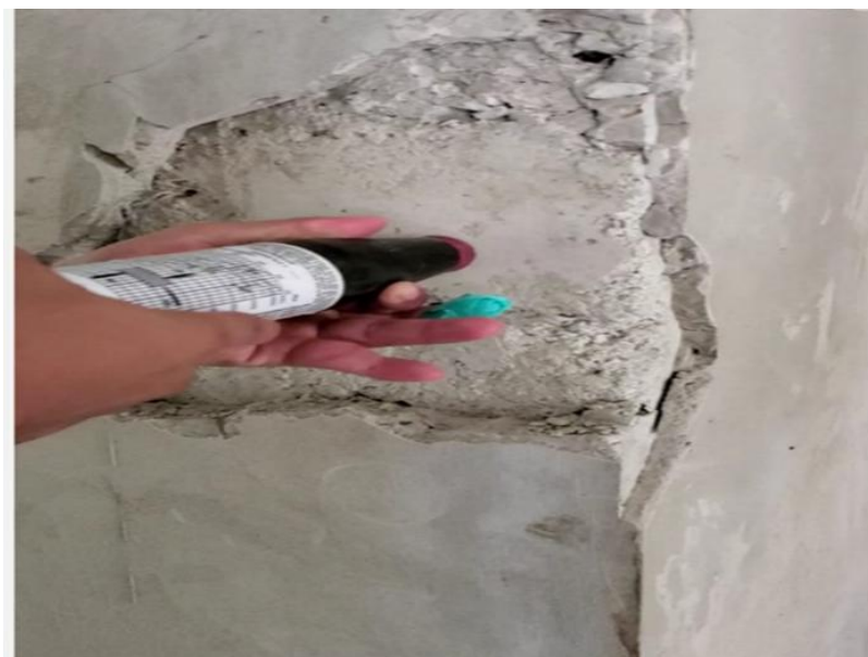
Figura 7. Esclerometría a columnas
