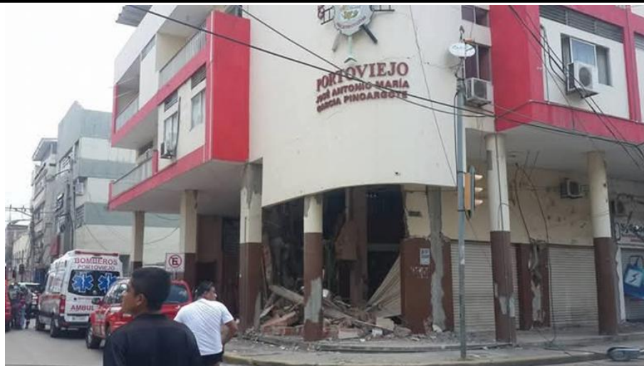
Figura 6. Edificio del Cuerpo de Bombero
