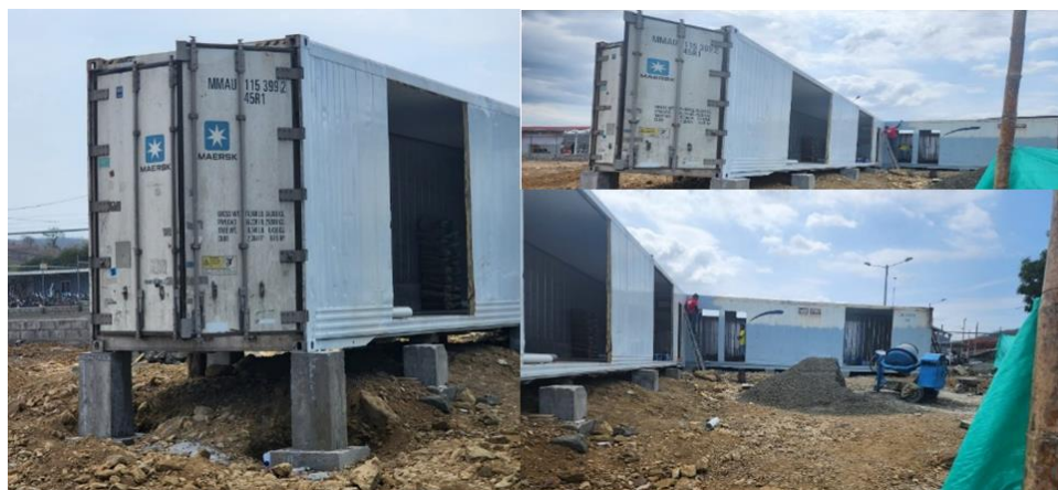
Figura 7: Cimentación mediante plintos para contenedores marítimos reutilizados.
