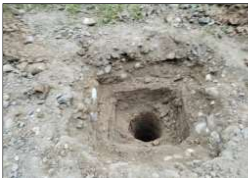
Figura 1. Calicata realizada en la vía Pambilar de Arriba y San Pablo del cantón El Carmen.
