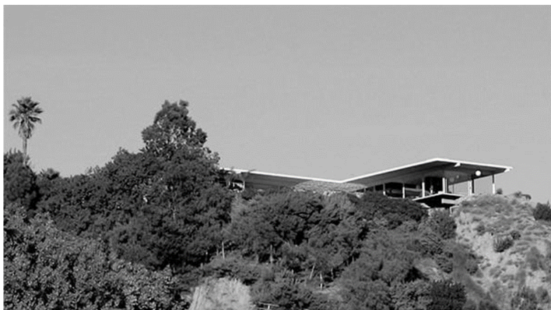
Figura 1. Casa Stahl vista desde el valle
