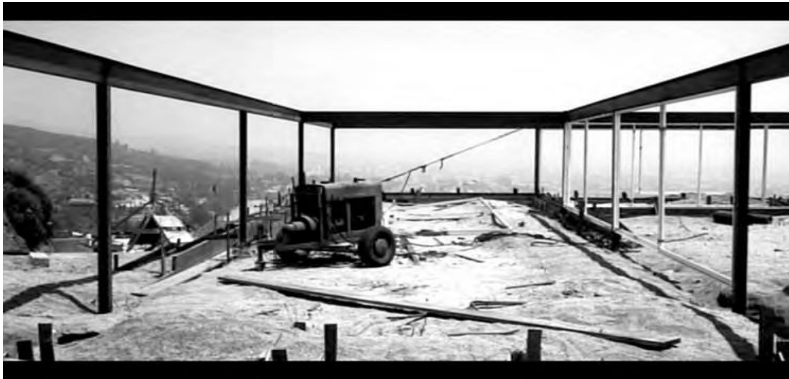
Figura 8. Estructura de la casa Stahl al comienzo de los trabajos de construcción.
