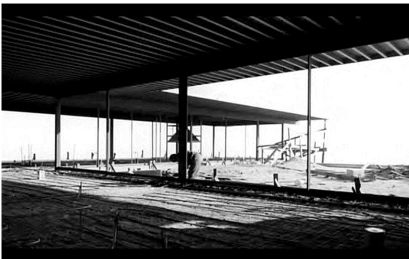
Figura 9. Casa Stahl en construcción al comienzo de la fase de instalación de calefacción por suelo radiante.
