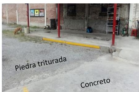
Figura 5. Instalación automotriz con material combinado del piso.
