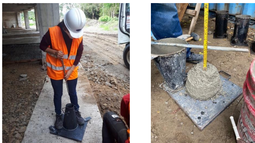
Figura 3. Ensayo del cono de Abrams para mezcla de hormigón tradicional. Elaborado por: Mary Robayo (2021)
