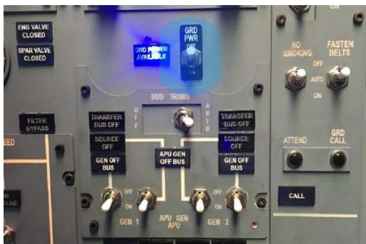
Figura.24. Interruptor GROUND POWER En posición OFF
