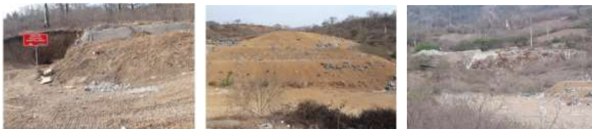
Figura 5: Secciones donde se depositan los residuos en el relleno sanitario del cantón Jipijapa.
