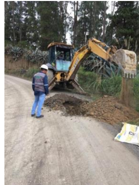
Imagen 2: Extracción de muestras de suelo
