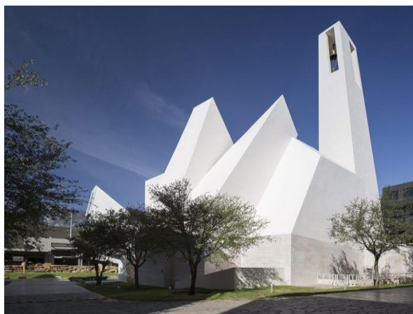
Figura 3. Iglesia entre tradición y modernidad.
