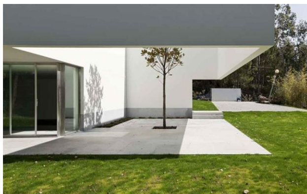
Figura 4: Vista de una vivienda luego del muro pantalla del exterior
