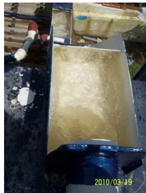
Descarga del agua cruda, proveniente del río, en el vertedero de recepción (etapa inicial)
