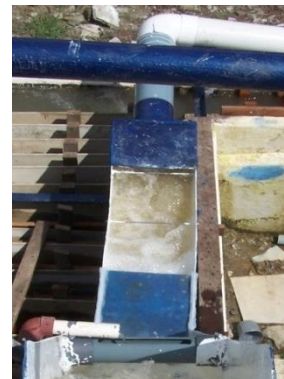
Mezcladora rápida - coaguladora (etapa final)
