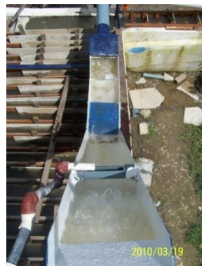
Precipitación hidráulica sobre la bandeja de dosificación laminar (etapa media)
