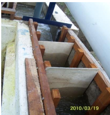
Descarga del agua coagulada en el canal de flujo rápido
